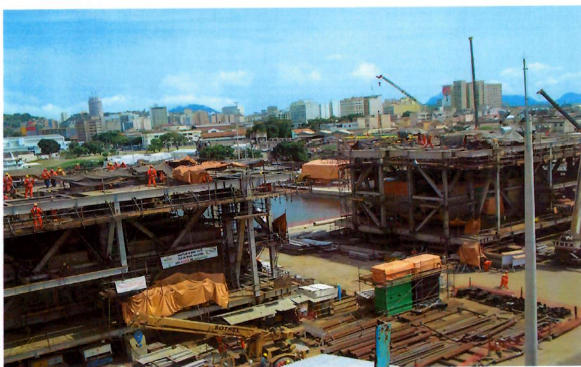
FOTO - 08 - Montagem da segunda seção dos módulos
