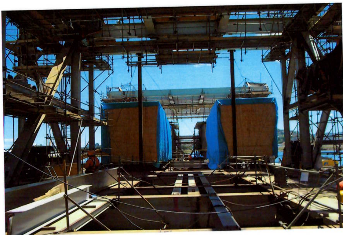
FOTO - 06 - Posicionamento dos geradores nos módulos
