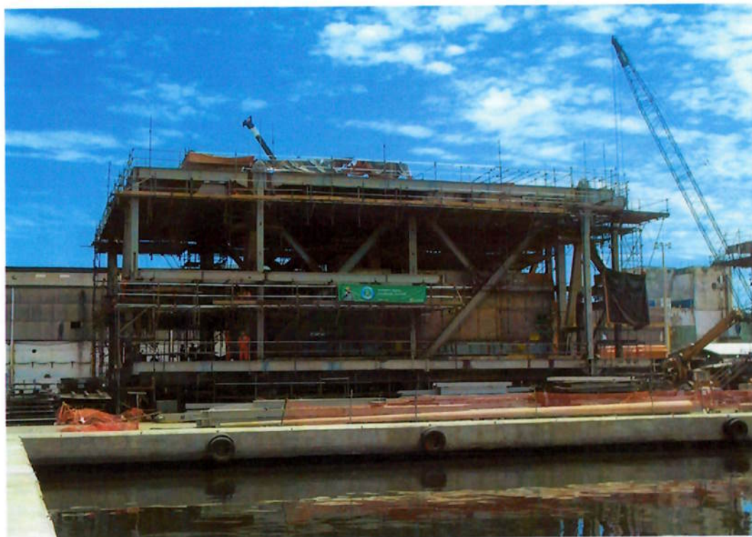
FOTO - 08 - Montagem da segunda seção dos módulos
